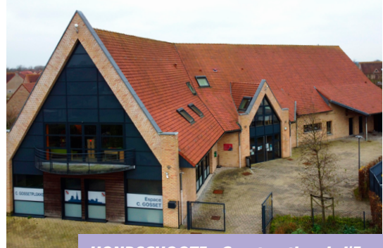
HONDSCHOOOTE - Construction de l'Espace Claude Gosset et Rénovation du Groupe Scolaire : 719 427 €
