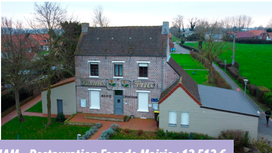
DRINCHAM - Restauration Façade Mairie : 12 512 €
