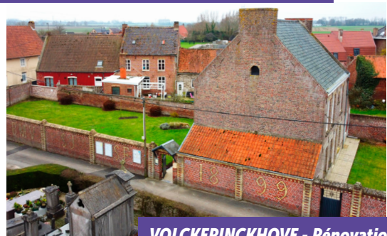
VOLCKERINCKHOVE - Rénovation du mur d'enceinte de la mairie : 3 115 €
