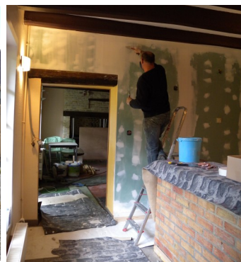
Salle du Four à Pain Pose d'une porte coulissante entre la salle et le bar.
