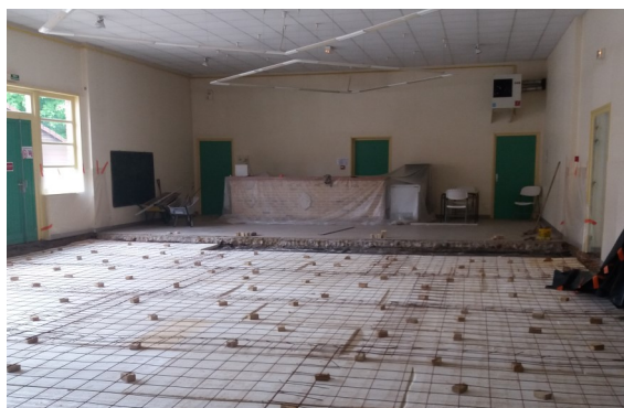
Salle Saint Joseph Remplacement du carrelage
