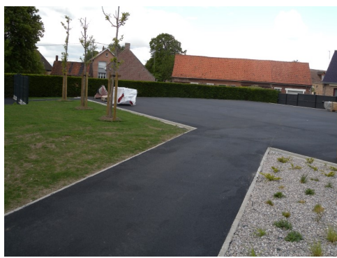
Le city stade Pose de la structure dès le 25 mai
